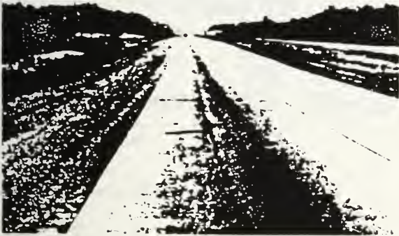
Fig. 3.2.4.1 — Longitudinal cracks
